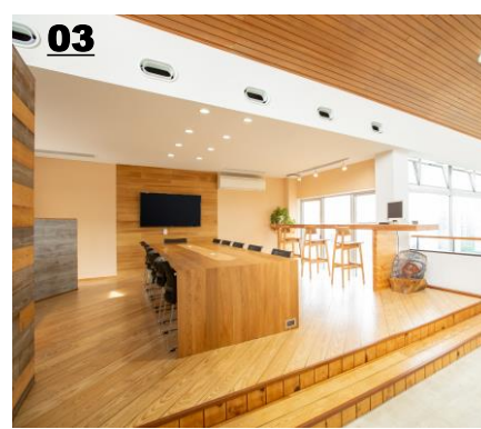
03 サンディング施工済みフローリング
